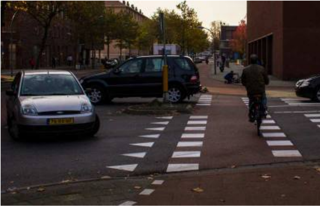
Figur 4 Tydlig väjningspliktsmarkering för bilister från båda hållen utan planskild cykelbana
